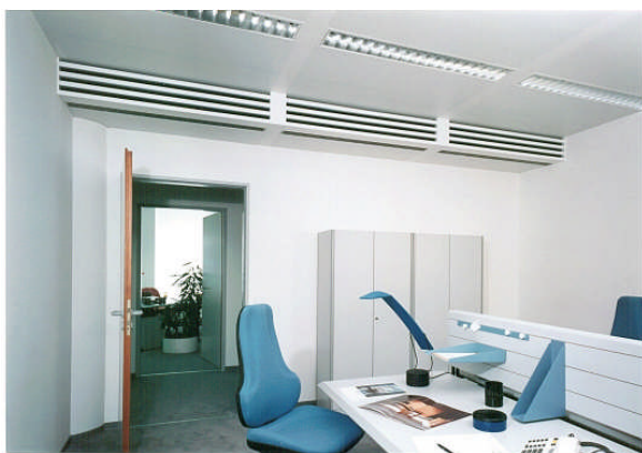
Installatievoorbeeld: Inductieunit, type: LHG
