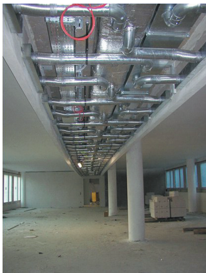
1. Plaatsing van kanalen en gangwandroosters in het gangplafondplenum.
